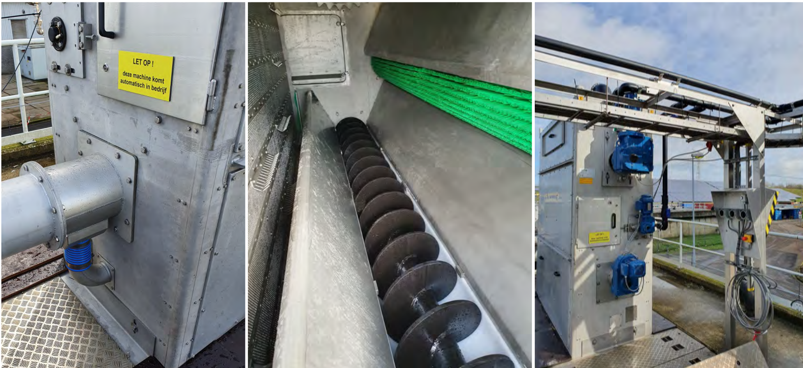
Foto's boven: geïntegreerde roostergoedpers in perforatierooster
