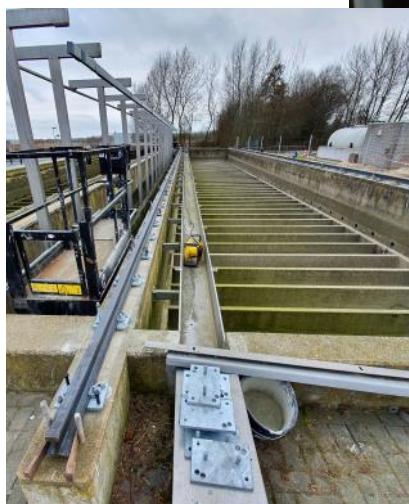
Foto boven: spoelarmen met actuators
