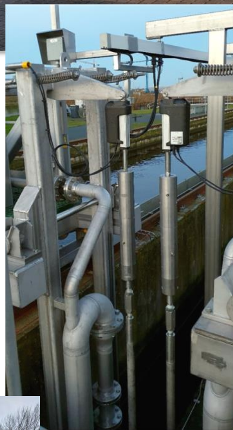
Foto boven: spoelarmen met actuators
